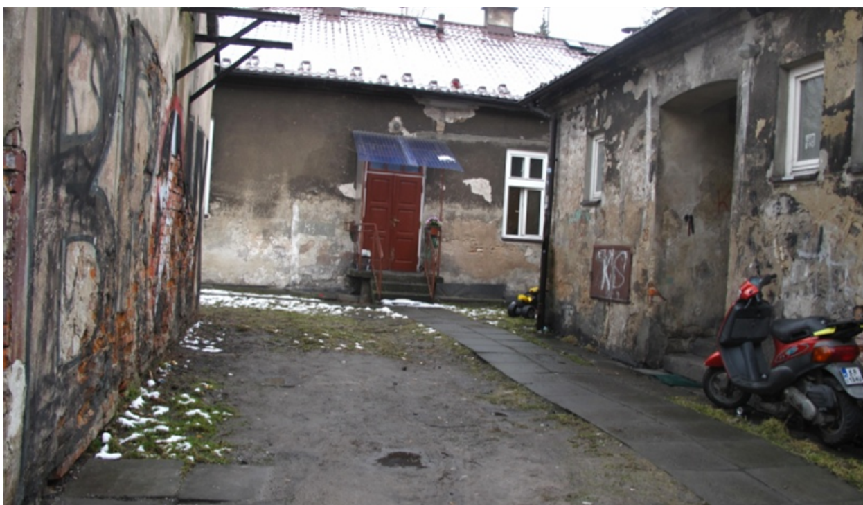
Podobszar 4 - budynki socjalne przy ul. Boża Wola.
