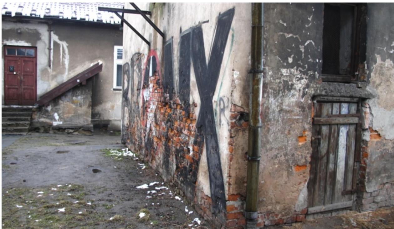
Podobszar 4 - budynki gospodarcze przy budynkach socjalnych.
