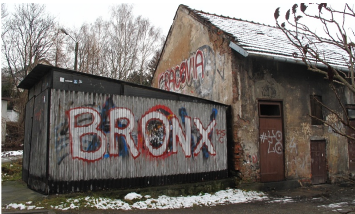
Podobszar 4 - budynki gospodarcze przy budynkach socjalnych.
