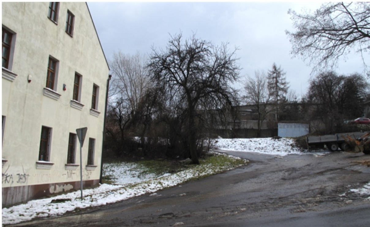
Podobszar 2 - obiekty mieszkalne przy ul. Kłaśnieńskiej.
