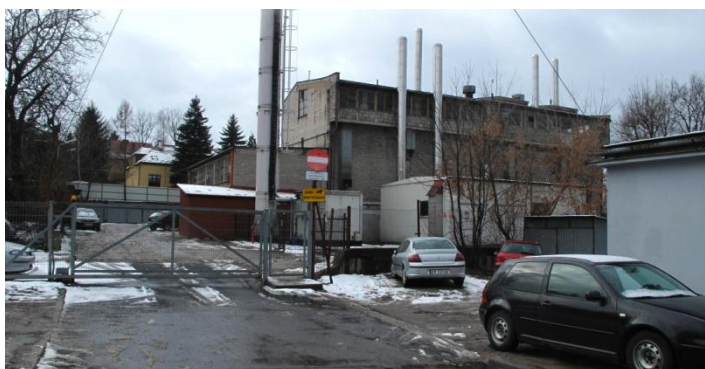
Podobszar 1 - teren nieczynnej ciepłowni wraz z opuszczonymi obiektami.
